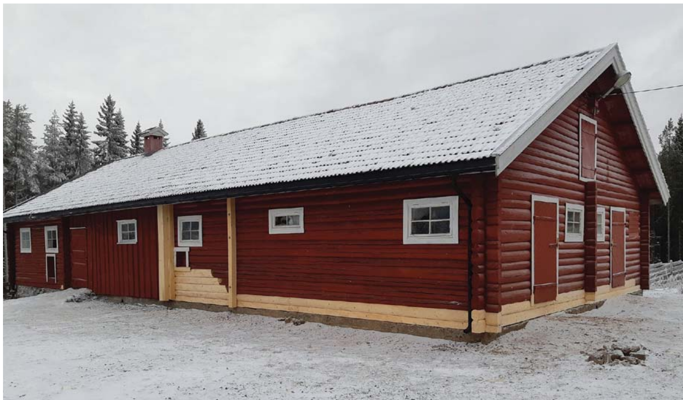
Restaurering av stall på Vesterås av Byggservice Innlandet AS
